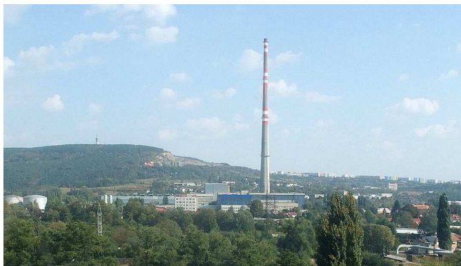
Obr. 3 Pohled na provoz Brno-sever
