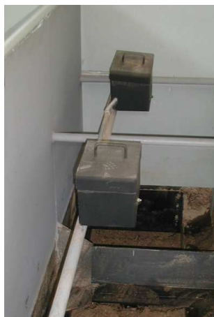
Obr. 13 Snímače hladiny paliva [5]
