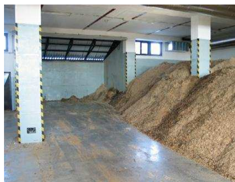
Obr. 24 Pohled do skladu štěpky
