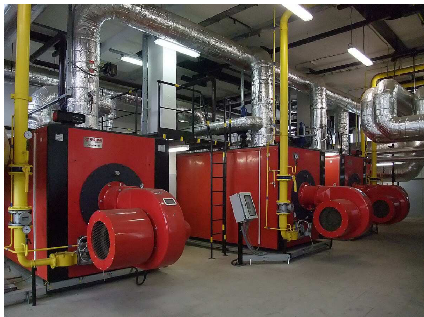
Obr. 22 Plynové kotle DYNATHERM
