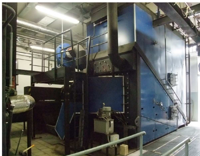
Obr. 20 Kotel VESKO-B 1,5 MW
