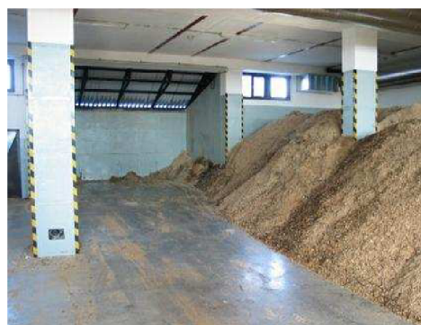
Obr. 24 Pohled do skladu štěpky
