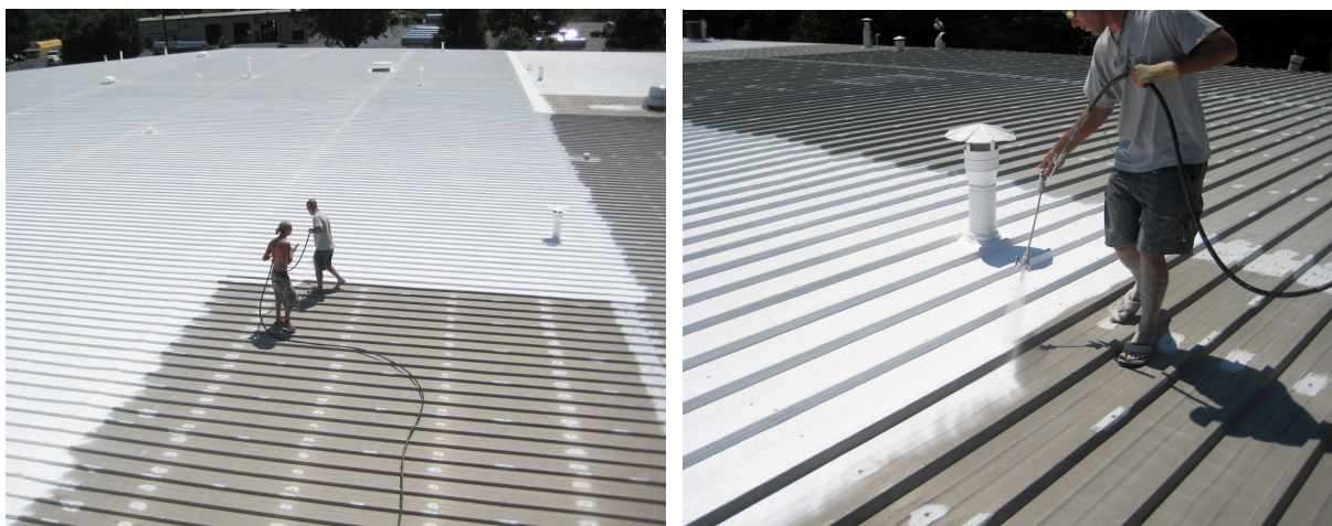
Obr. 7 - Aplikace elastomerního nástřiku na střechu ( http://peter4gov.org/5426-spray-coatings-for-metal-roofs/ )
