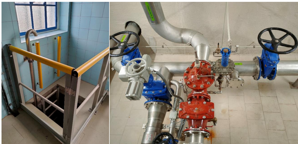
Obr. 3.9 VDJ Suchohrdly – sestup do armaturní komory a armaturní komora. Foto Marie Bergerová
