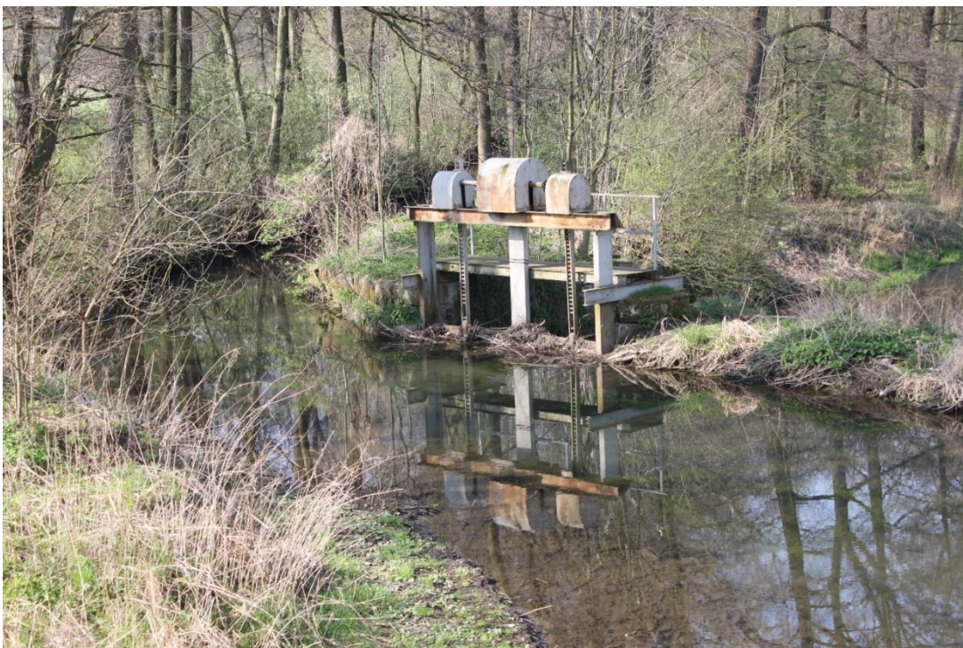
Obr. 12: Stavidlo v Nedošíně 192
