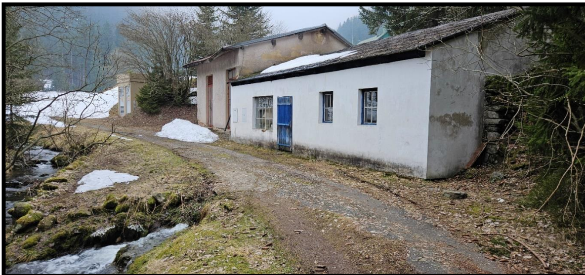
Obrázek 13 - Budova MVE (J. Lakomý, 2024)
