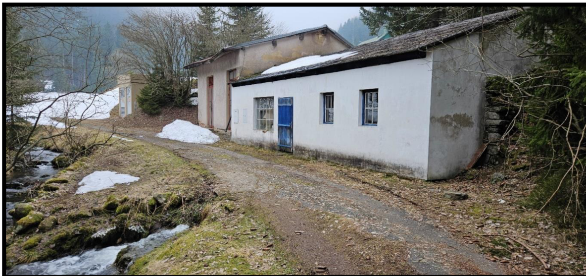
Obrázek 13 - Budova MVE (J. Lakomý, 2024)
