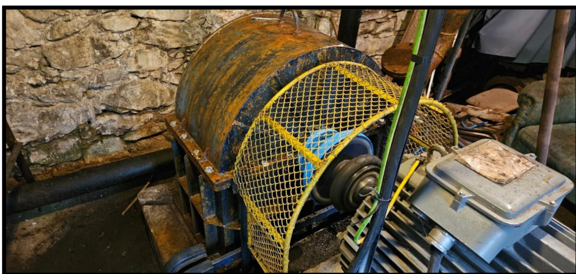
Obrázek 14 - Peltonova turbina Jelení louka (J. Lakomý, 2024)
