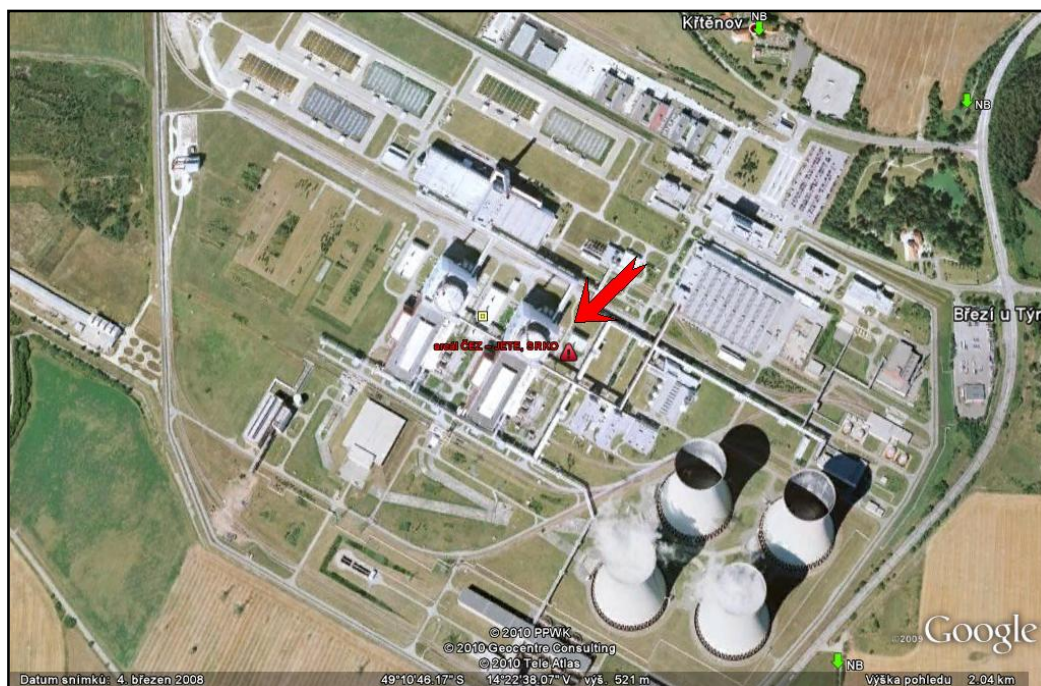
Obrázek č. 4: Areál ETE – pata prvního bloku reaktoru – červená šipka
