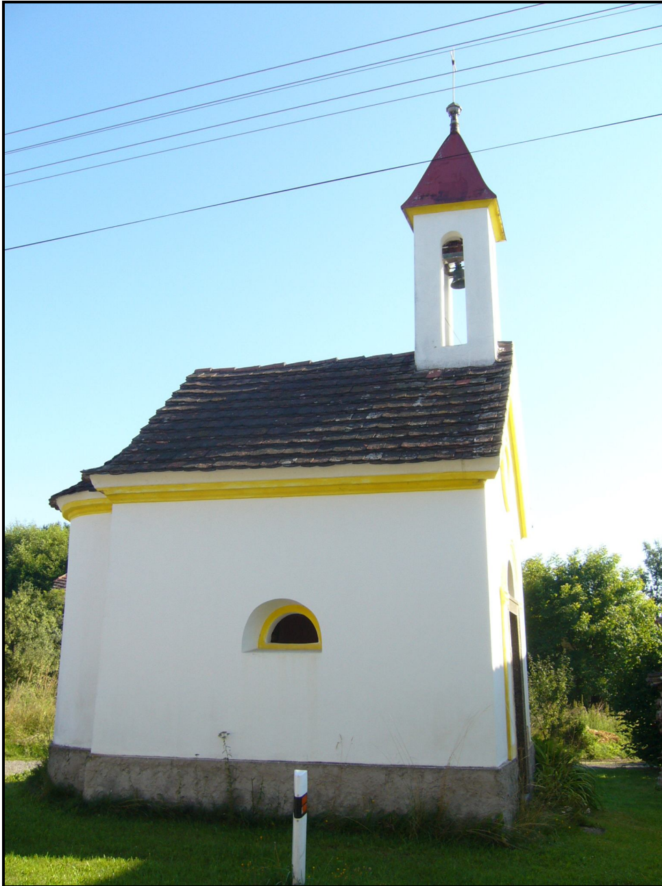
Fotografie č.9 – kaple v obci Pohorovice (VB)
