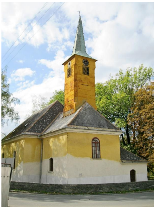
1. Šternberk, kostel Nejsvětější Trojice, pohled na presbytář.
