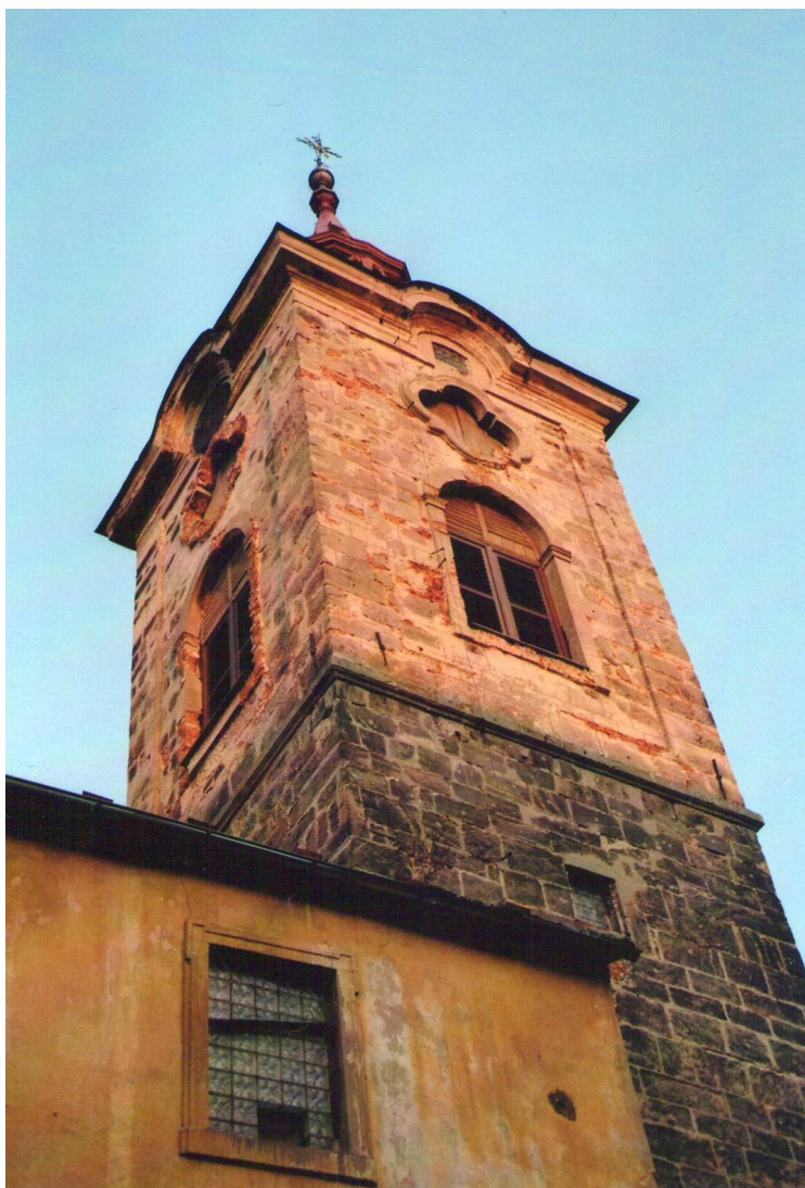
Foto 5. Jičín, kostel sv. Ignáce z Loyoly, detail věže. (Foto archiv autorky)
