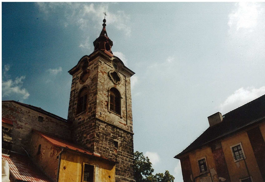
Foto 7. Jičín, kostel sv. Ignáce z Loyoly, pohled ze dvora Jezuitské koleje. (Foto archiv autorky)
