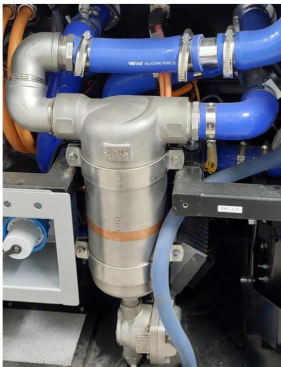
Obrázek 12: Zástavba současného řešení do vodíkového systému
