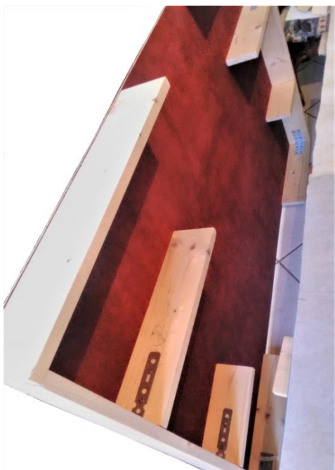
Obr. 13: rám přilepený k zadní desce s viditelnými podpěrami a úhelníky
