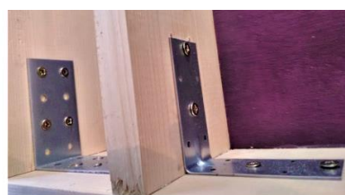
Obr. 28: úhelníky spojující rám
