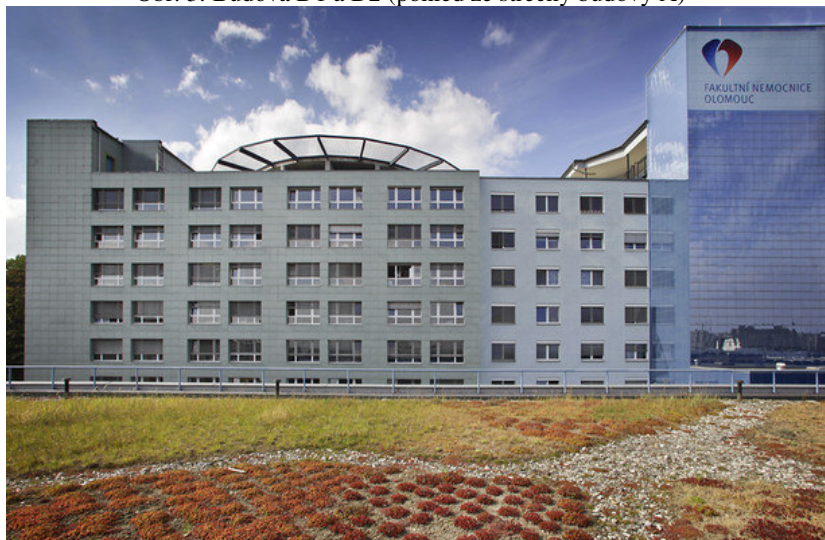
Obr. 3: Budova D1 a D2 (pohled ze střechy budovy A)
