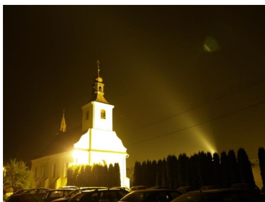
Obr. 7 Nevhodné nasvícení objektu (zdroj: Světelné znečištění, 2018a).
