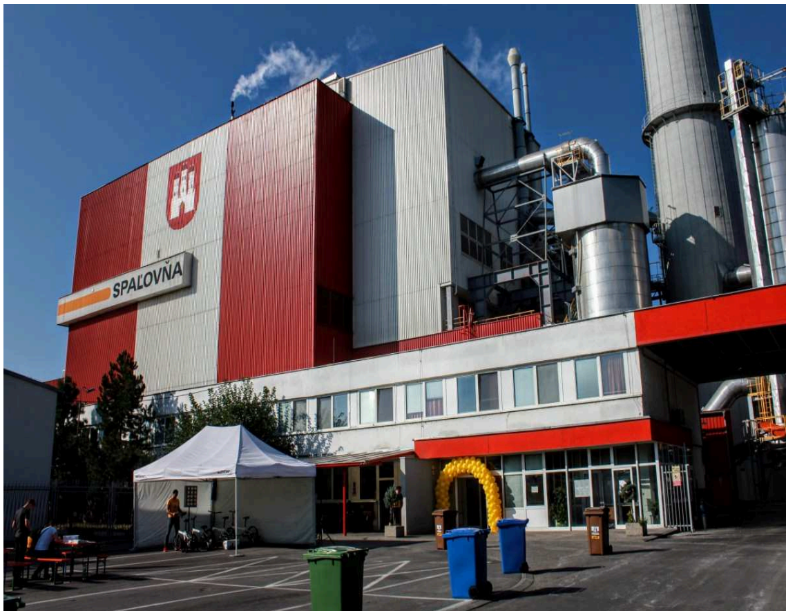
Obr. 2.11 Spalovna odpadů v Bratislavě
