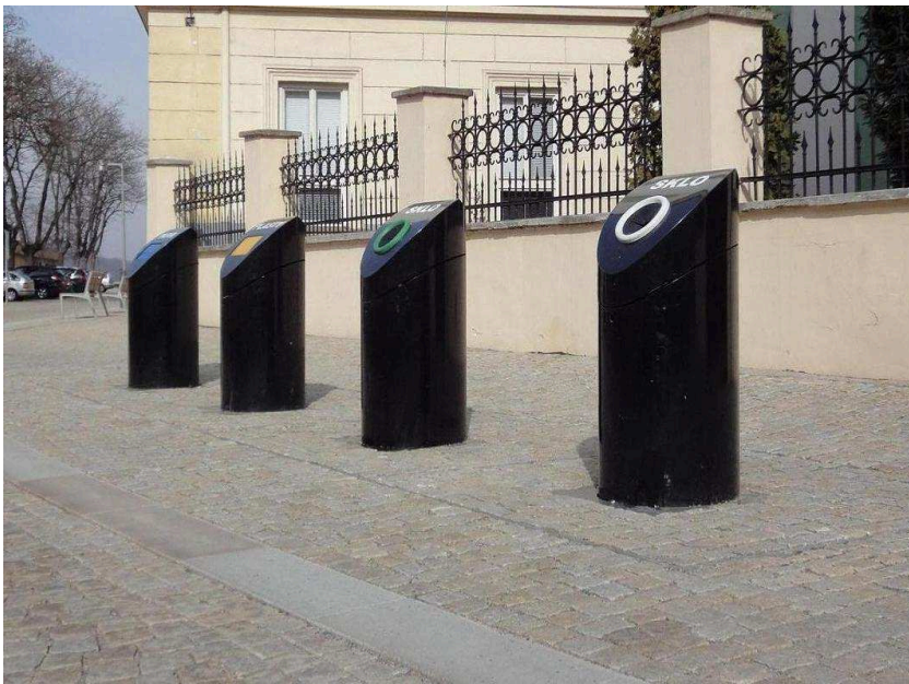
Obr. 3.2 Podzemní kontejnery ve Znojmě
