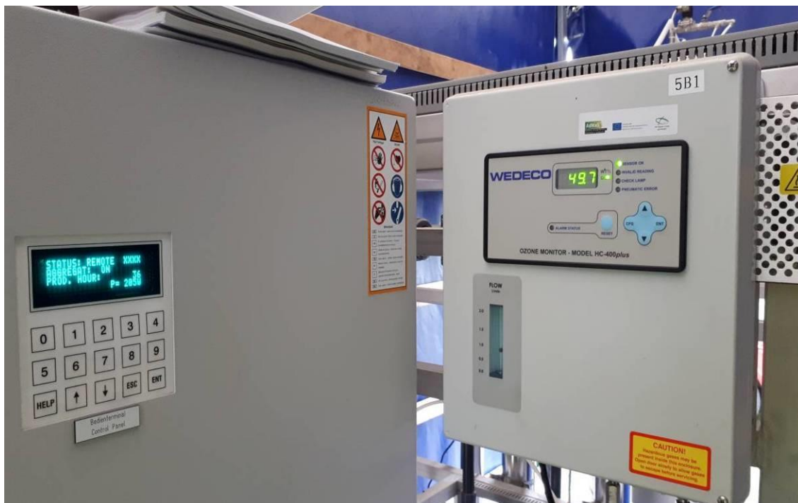
Obr. 41 Display s hodnotou koncentrace ozonu v plynu
