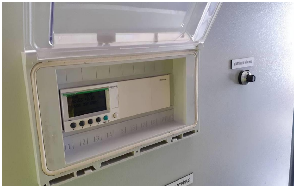
Obr. 42 Display a otočné ovládání nastavení výkonu ozonizátoru
