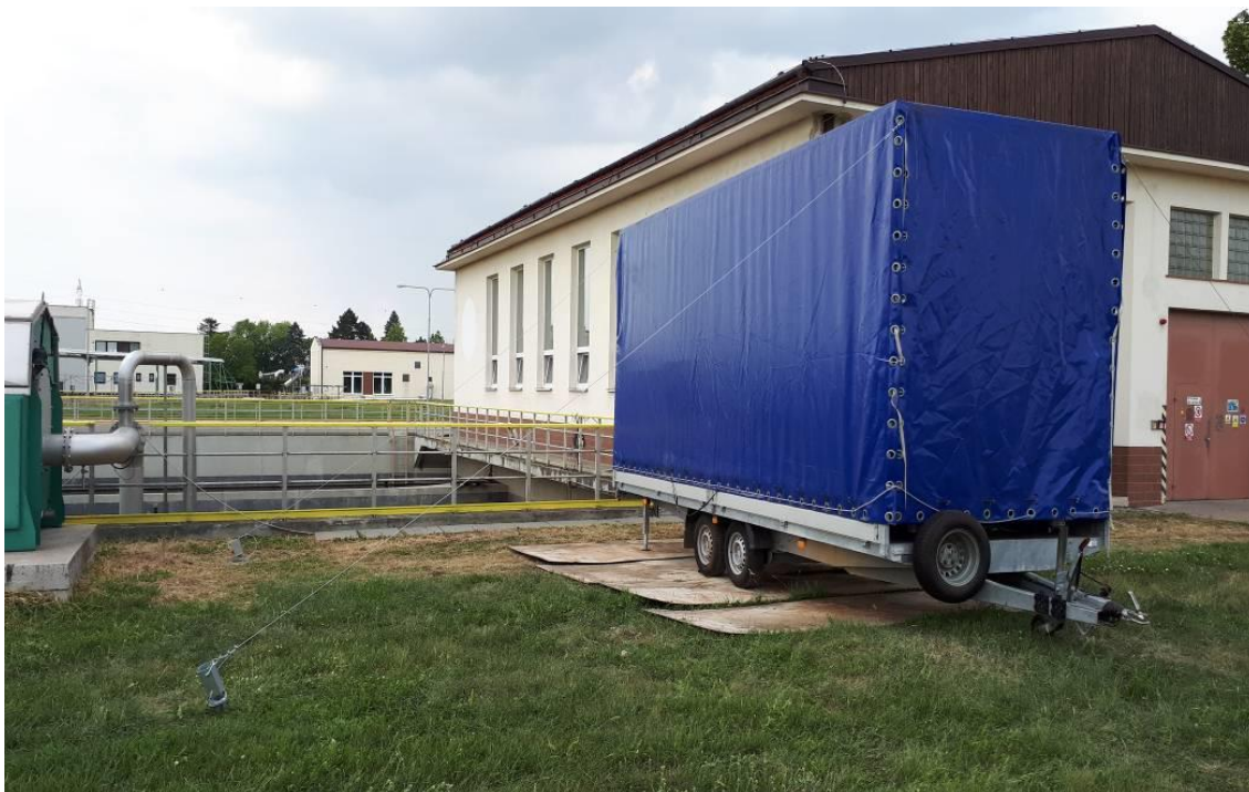
Obr. 36 Konečné umístění a ukotvení přívěsu pomocí ocelových lan a kotvicích prvků z důvodu stability
