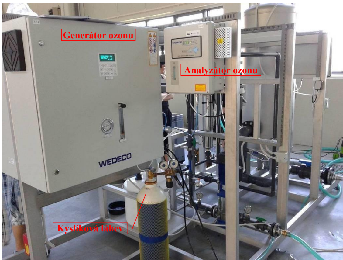
Obr. 20 Pohled na řídicí skříně s generátorem ozonu, analyzátor a kyslíkovou láhev
