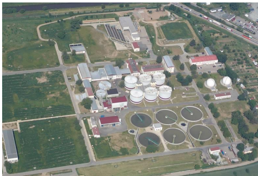
Obr. 33 ČOV Brno - Modřice [54]
