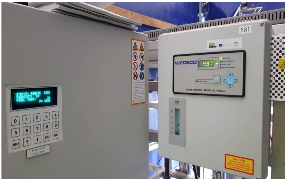
Obr. 41 Display s hodnotou koncentrace ozonu v plynu
