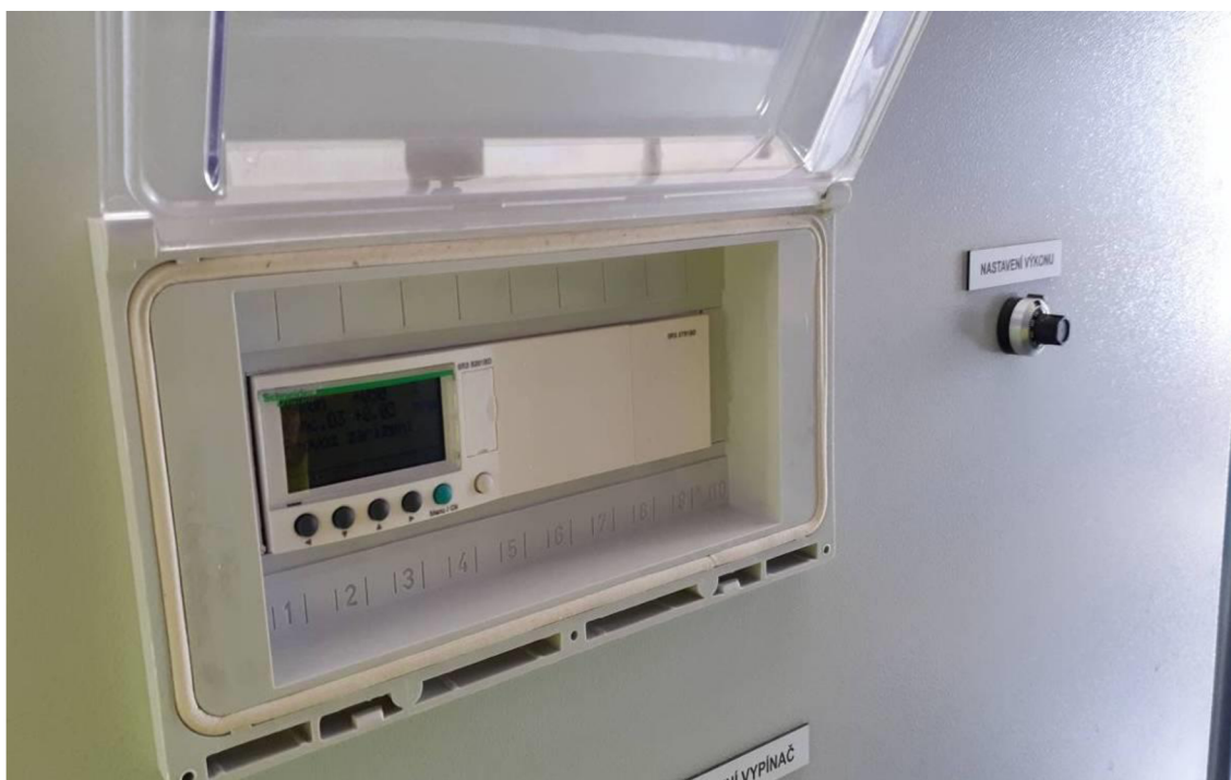
Obr. 42 Display a otočné ovládání nastavení výkonu ozonizátoru
