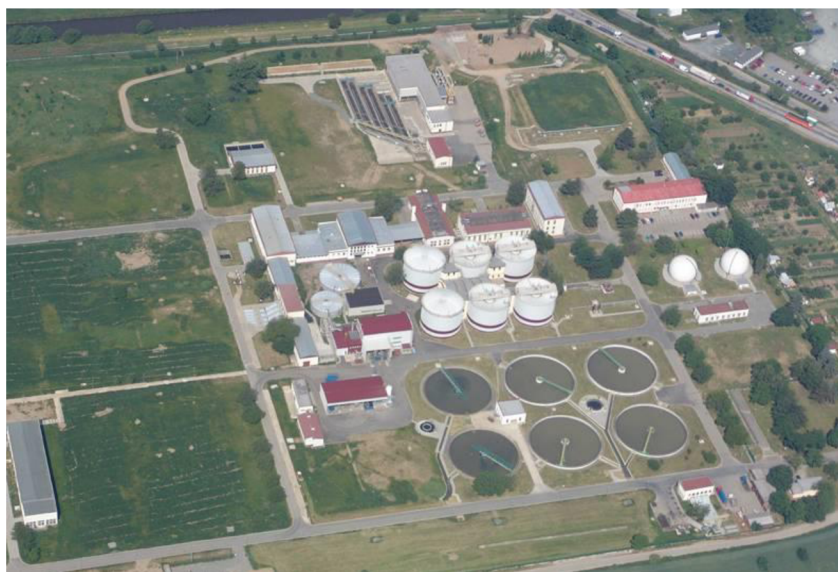
Obr. 33 ČOV Brno - Modřice [54]
