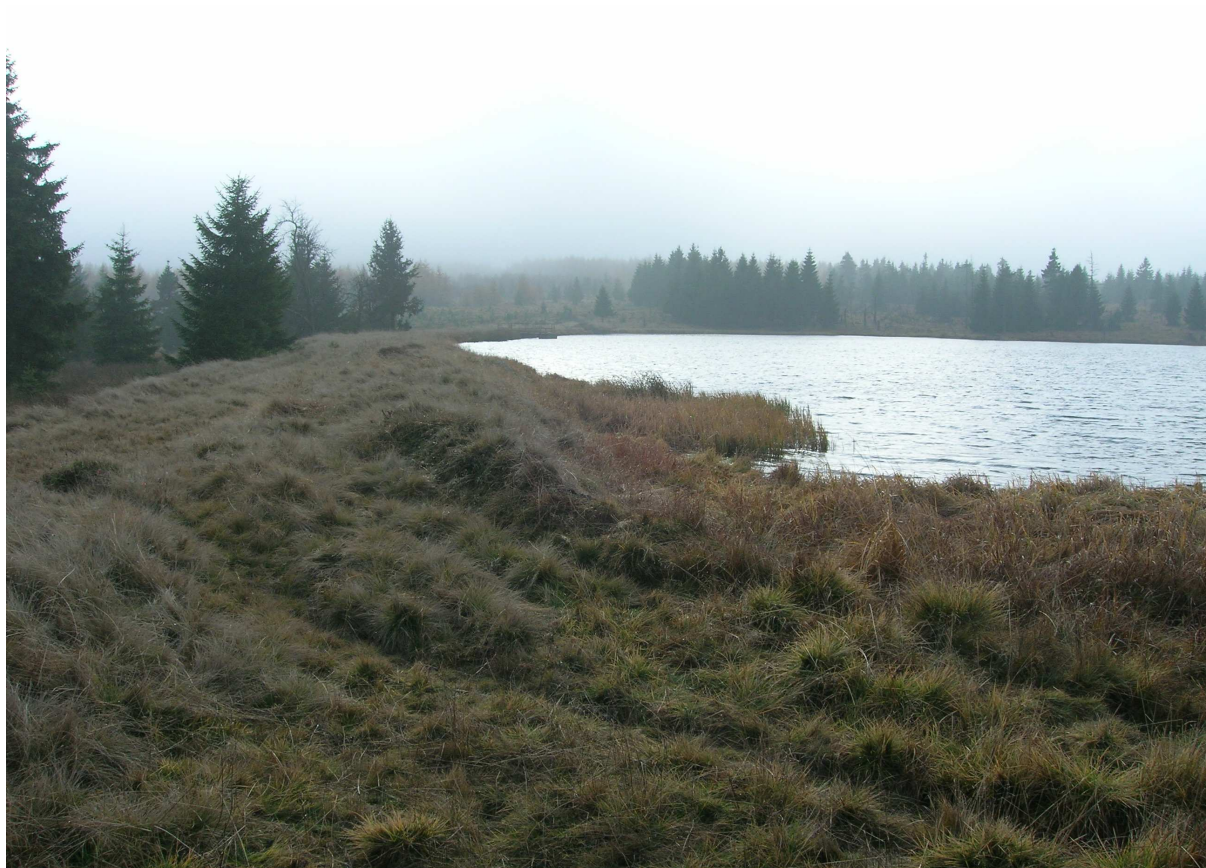
Foto 5. Pohled na hráz z místa bezpečnostního přelivu– podzim 2008
