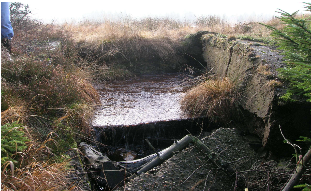
Foto 3. Pohled na bezpečnostní přeliv z koryta navazující na BP– podzim 2008
