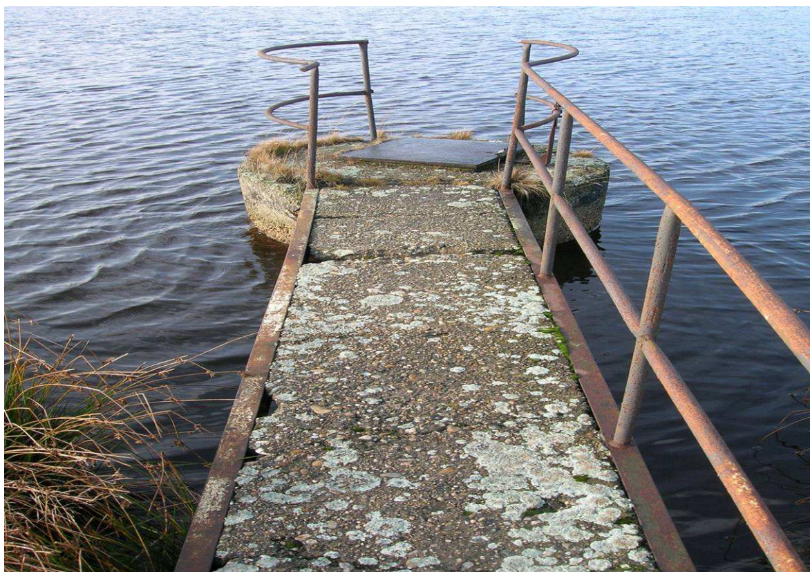
Foto 6. Pohled na požerák z hráze– podzim 2008
