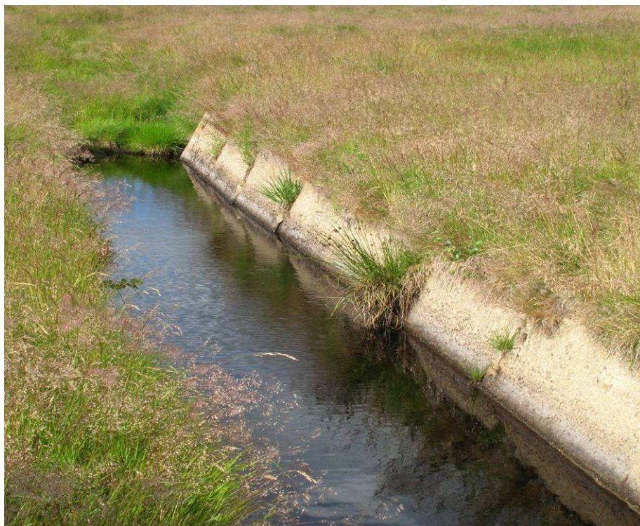
Foto 9. Pohled na obetonované koryto Chomutovky v místě návrhu rozdělovacího objektu - léto 2008
