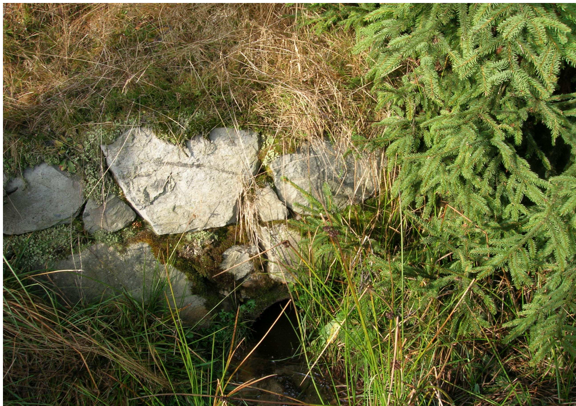
Foto 7. Pohled na výpustné potrubí a na čelo výpusti na návodní straně hráze– podzim 2008
