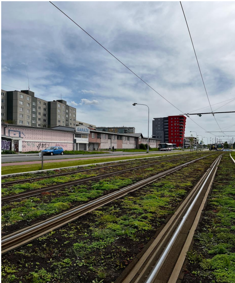
Obr. 11: Tramvajový pás s rozchodníky ve Schweitzerově ulici Zdroj: vlastní fotografie, 28. 4. 2024
