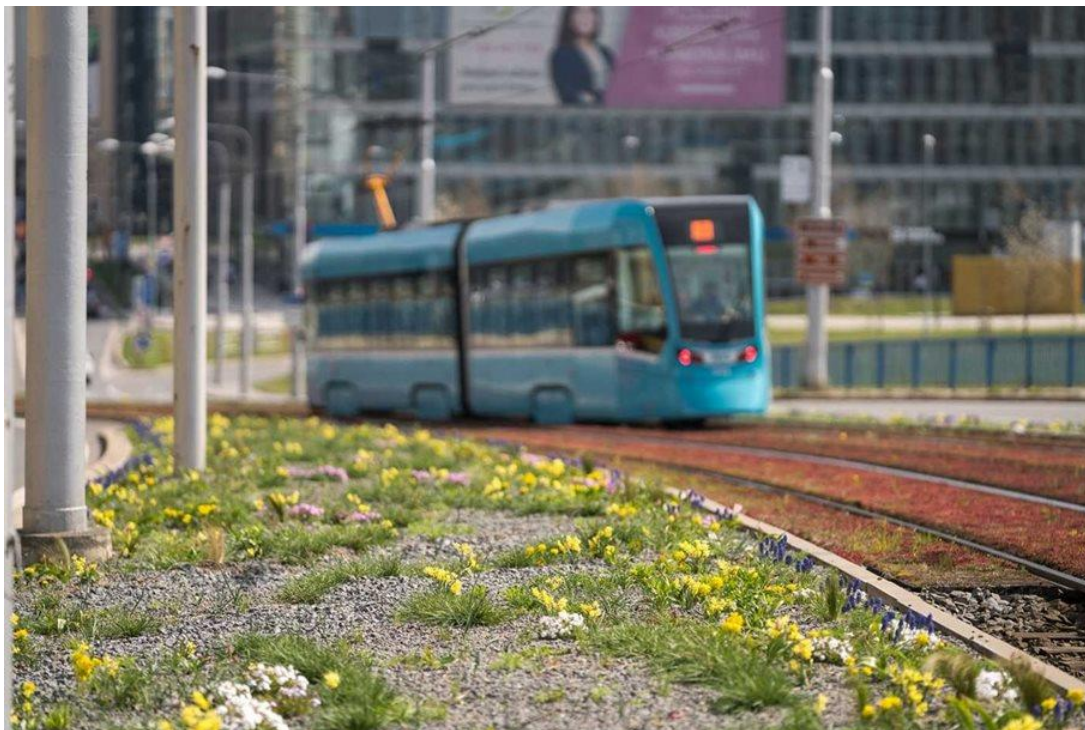
Obr. 4: Rozchodníkový pás na Frýdlantských mostech, Ostrava
