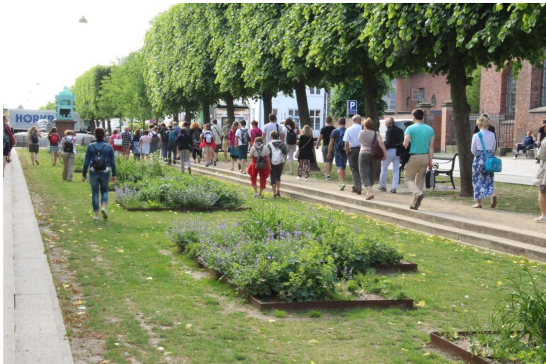
Obr. 5: Náměstí sv. Anny se sníženou střední částí pro odvod srážkové vody
