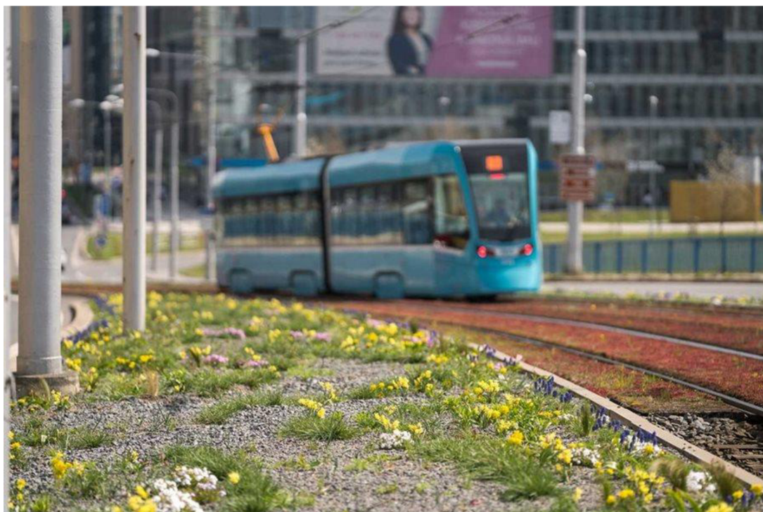
Obr. 4: Rozchodníkový pás na Frýdlantských mostech, Ostrava
