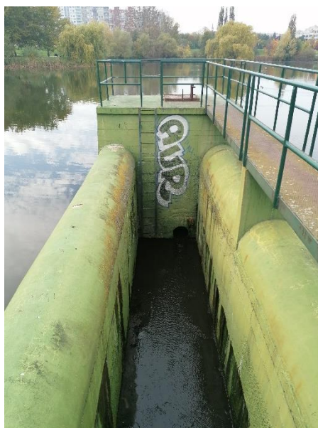
Obr. 12 Přeliv s vývařištěm na RN N1 (© S. Mecová, říjen 2022)
