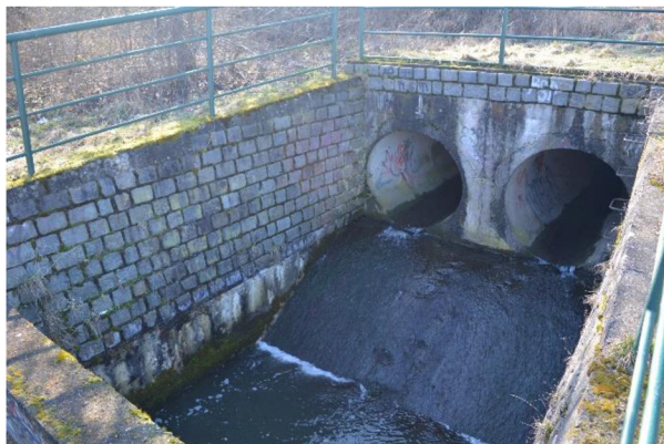
Obr. 16 Propustek a vývar na konci zatrubněného úseku toku pod RN N2 (© S. Mecová, březen 2023)
