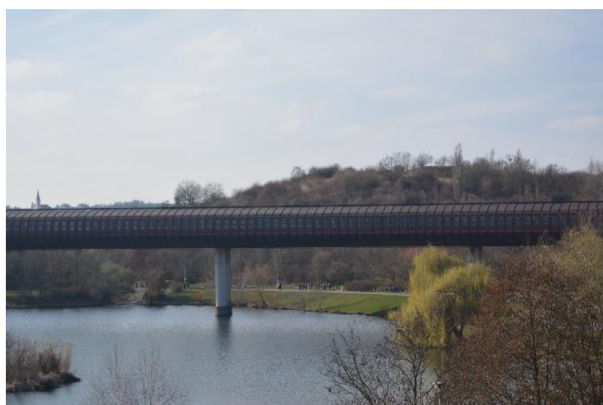
Obr. 17 Deponie "Makču Pikču", pohled na JV svah (© S. Mecová, březen 2024)
