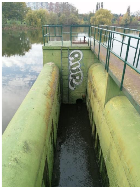
Obr. 12 Přeliv s vývaříštěm na RN N1 (© S. Mecová, říjen 2022)
