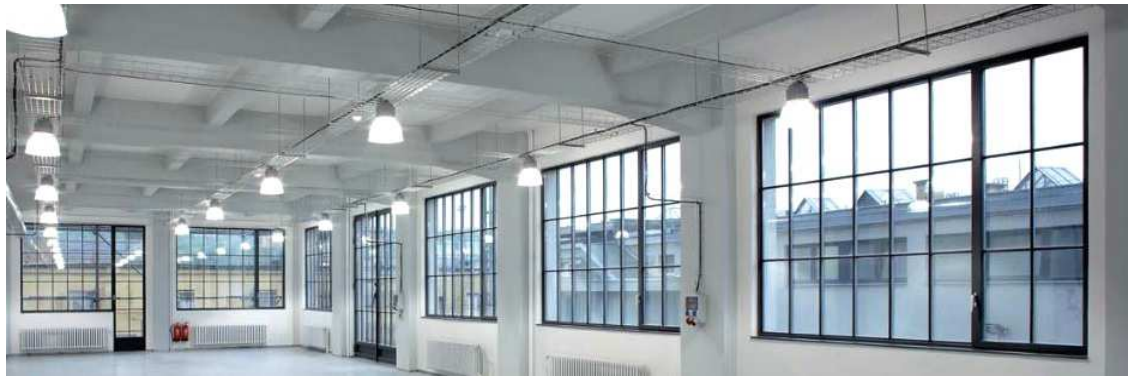
Obr. 28 Tabulková okna v interiéru tiskárny AF BKK v Praze
