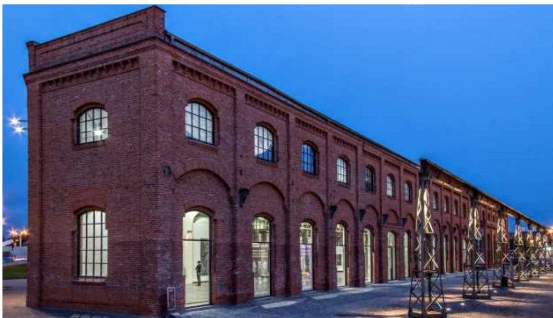
Obr. 14 Budova strojírny dnes Adam Gallery
