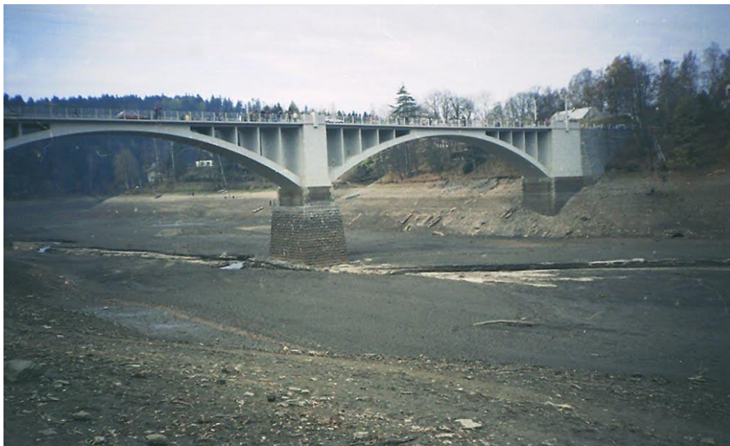
Obr. 3 Železobetonový viadukt přes přehradu (www.obecpastviny.cz)
