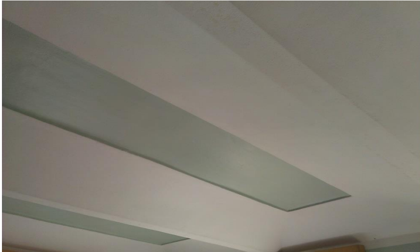
Obr. 20 Klenba nacházející se v kuchyni v přízemí
