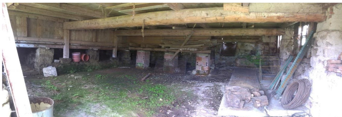
Obr. 27 Prostor pod zónou S-02 a S-03
