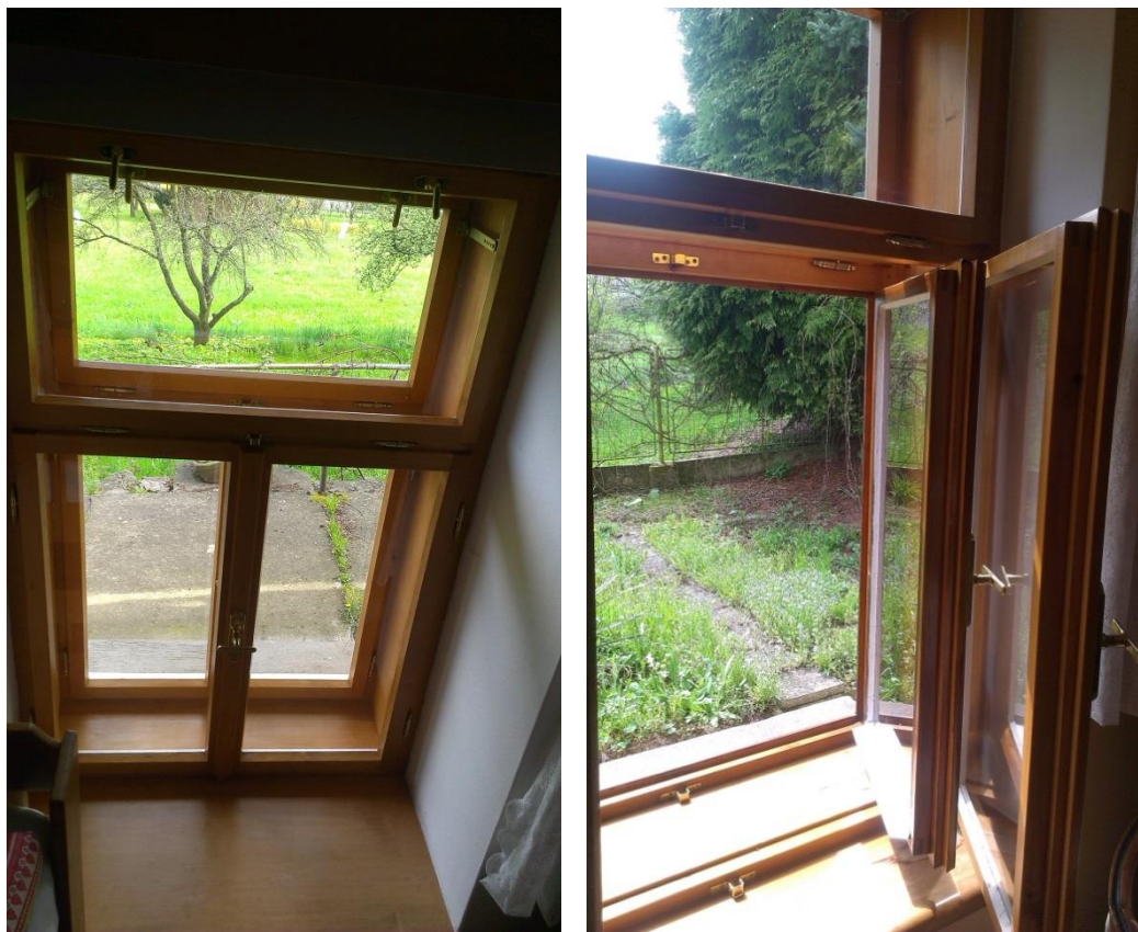
Obr. 22 Špaletové okno v místnosti A-03
