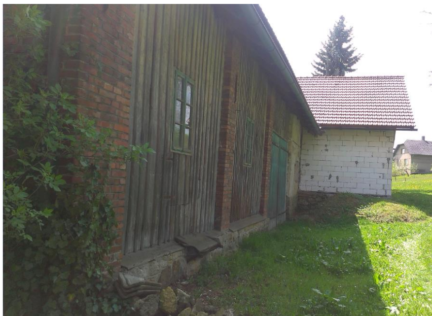
Obr. 24 Stodola – pohled severozápadní
