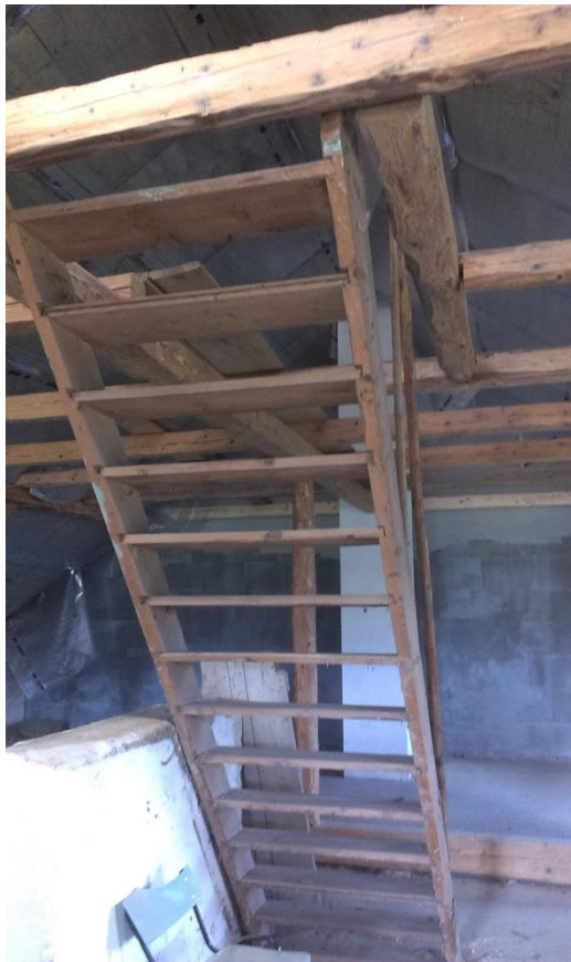
Obr. 16 Stávající schodiště na půdu, která se nachází nad podkrovím
