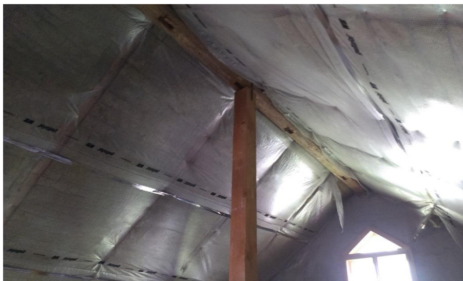
Obr. 29 Izolace mezi krokvemi, parozábrana
