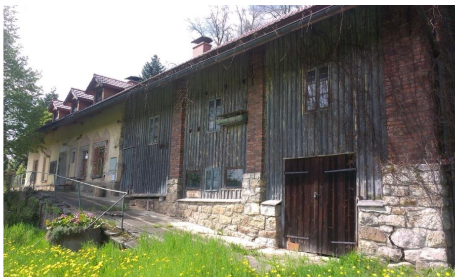
Obr. 8 Objekt s přilehlou stodolou – jihovýchodní pohled
