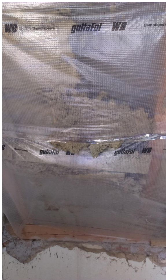
Obr. 30 Poškozená izolace mezi krovy
