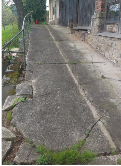
Obr. 32 Chodník, pod kterým je veden elektrický kabel
