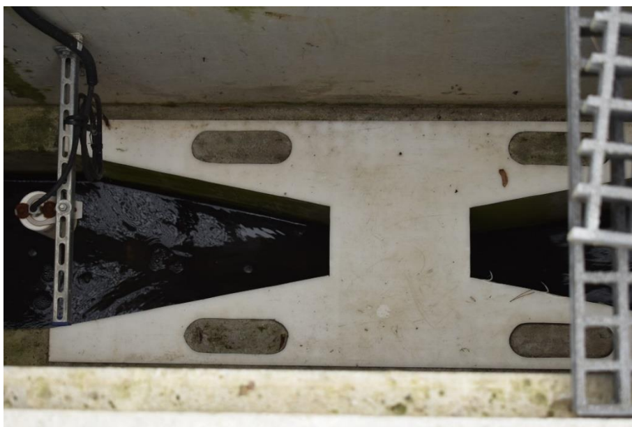
Obrázek 14 Detail Parshallova žlabu
