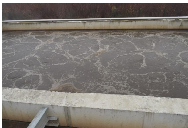
Obrázek 10 Detail v nitrifikační nádrži
