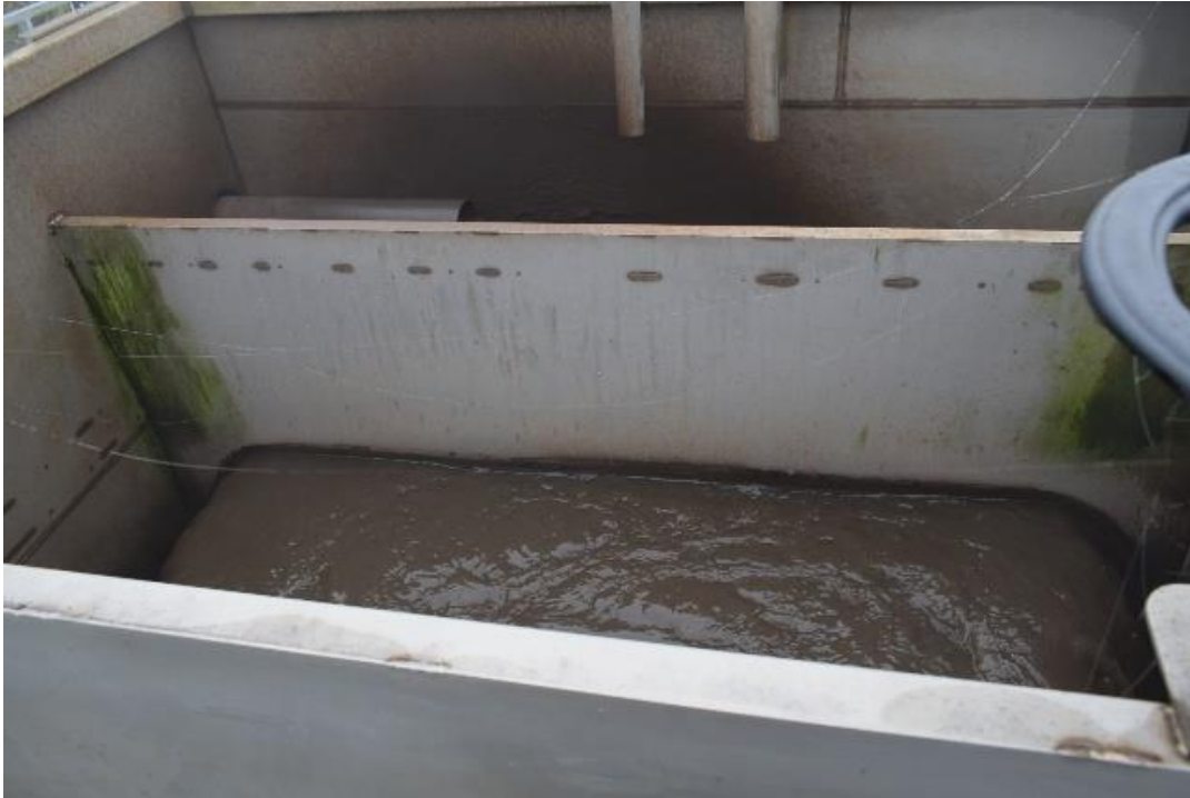
Obrázek 12 Rozdělovací objekt
