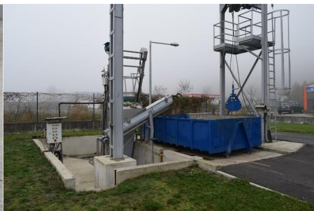
Obrázek 5 Česle se šnekovým dopravníkem
