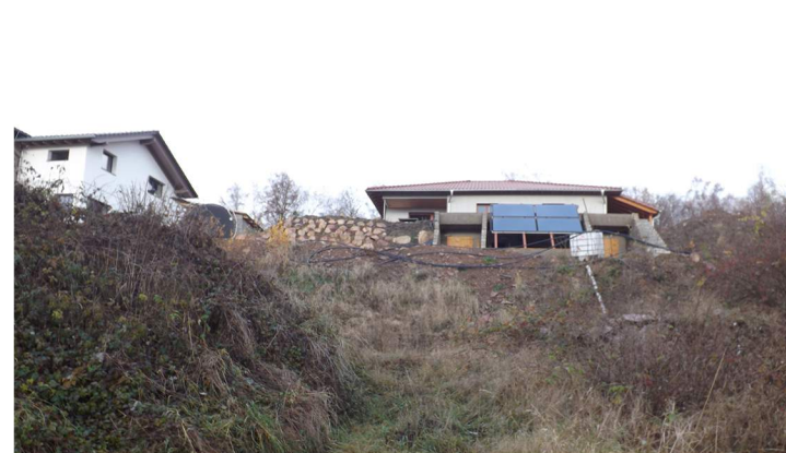
Fotografie č. 2 - Pohled na dům č. 3 z jižní části zahrady. Uprostřed vchodů do sklepů jsou umístěny solární panely.
