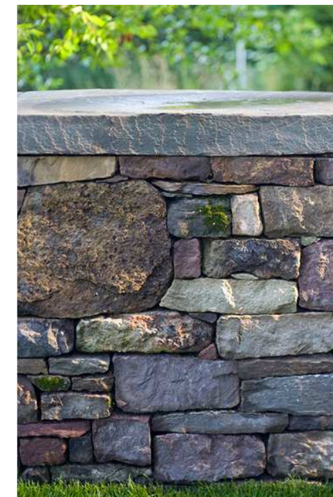
Obr. č. 14: Stavební princip přibetonované zdi z přírodního kamene a ukázka realizace
