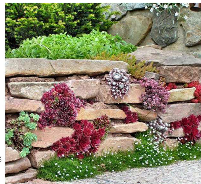
Obr. č. 13: Stavební princip suché zídky a realizace z pravoúhlých kamenů, které jsou srovnány do střídavých vrstev vytvářející stavbu (Zdroj: Wirth, 2009; http://www.stavimedum.cz/op%C4%9Brn%C3%A9-z%C3%ADdky/ ; vlastní zpracování autorky).
