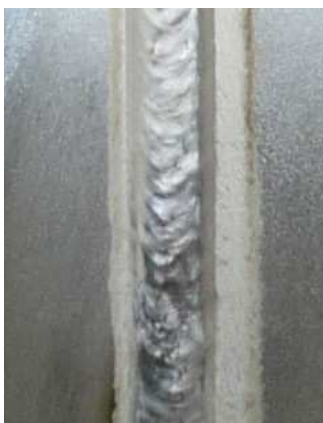
Obrázek 55 První vrstva svaru, strojní svařování, vlastní zdroj
