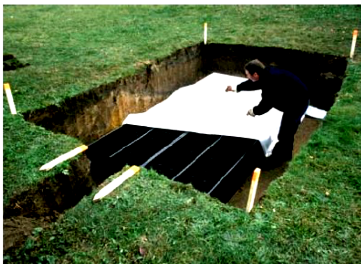
Obrázek 10: Pokládka vsakovacích bloků a geotextilie (zdroj: Kabelková a kol., 2015).
