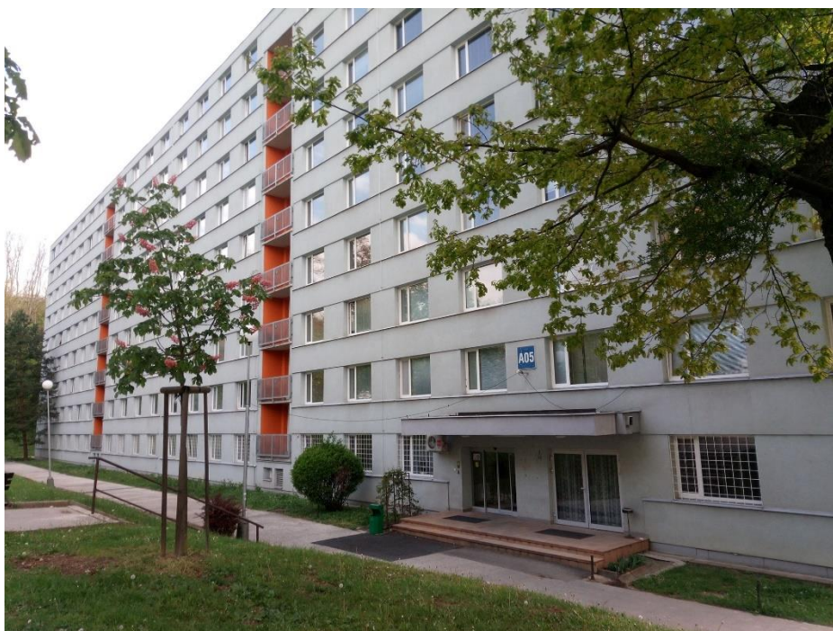
Obr. 12 Blok A05 kolejí Pod Palackého vrchem
