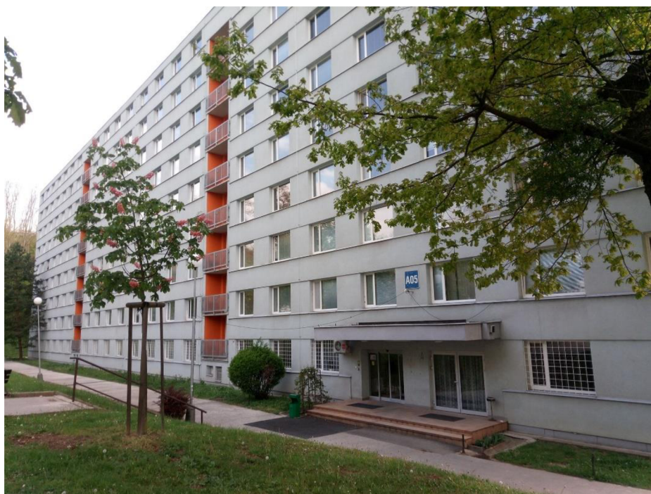
Obr. 12 Blok A05 kolejí Pod Palackého vrchem
