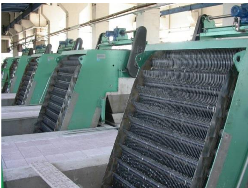
Obr. 8 Samočistící česle pásové [4]
