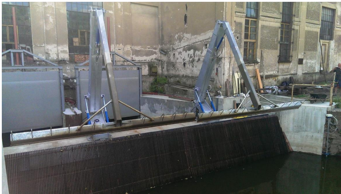
Obr. 13 Hydraulické česle dvouramenné [11]
