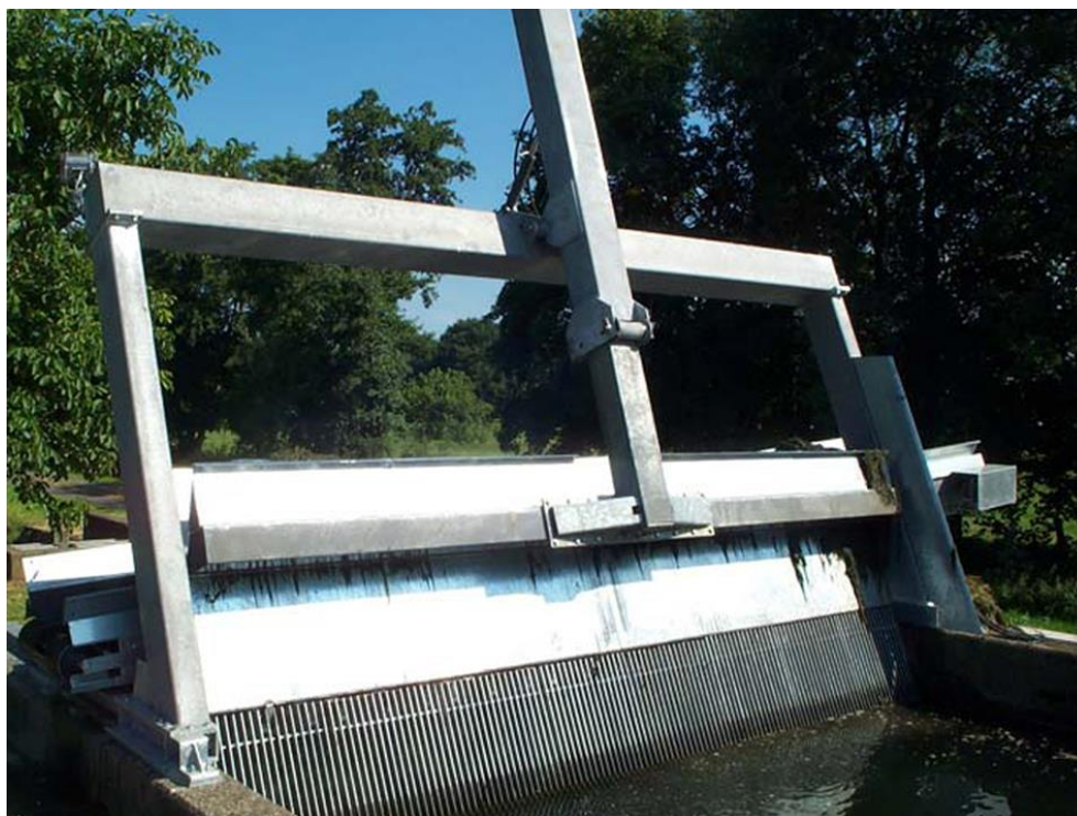
Obr. 12 Hydraulické česle teleskopické [10]
