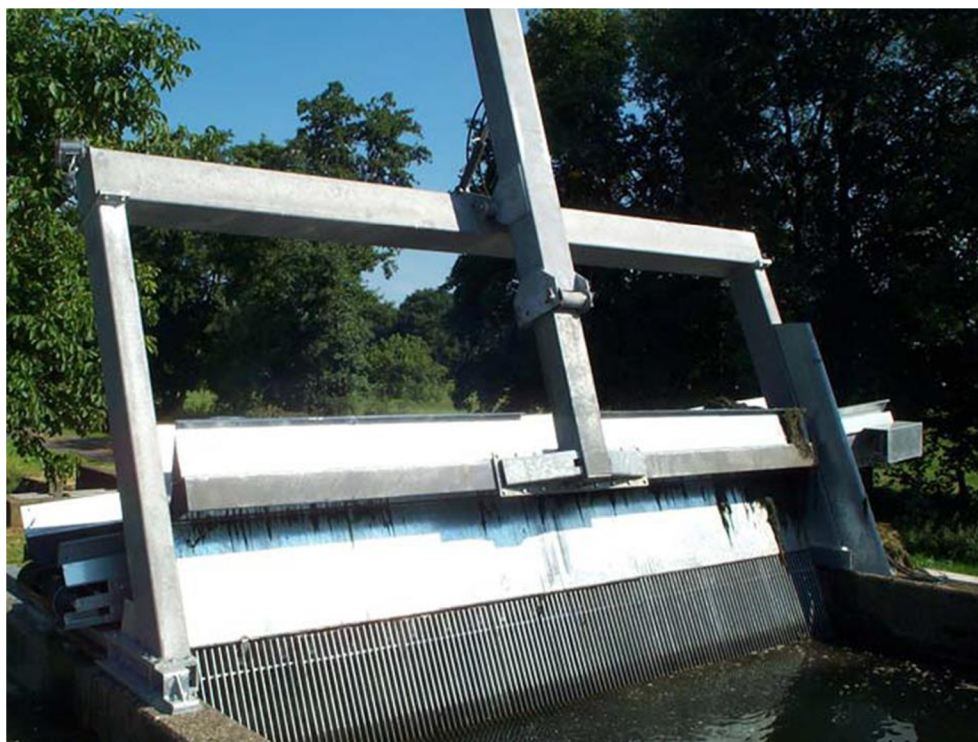
Obr. 12 Hydraulické česle teleskopické [10]
