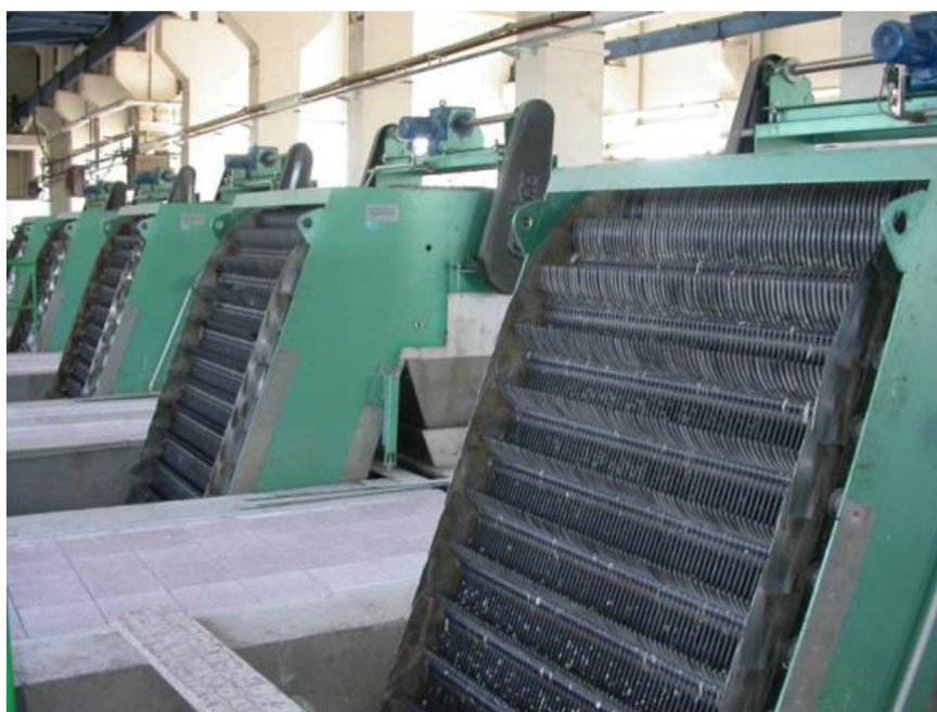
Obr. 8 Samočistící česle pásové [4]
