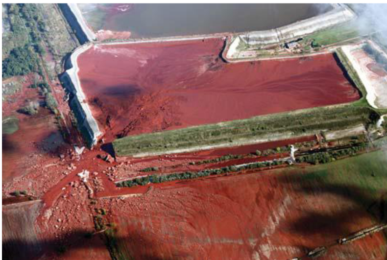
Obr. 7) Protržená hráz na odkališti [19]
