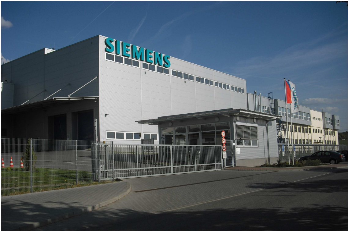
Obr. č. 1: Závod Siemens Electric Machines, s.r.o. v Drásově (Iva Schallerová, 24.4.2009)
