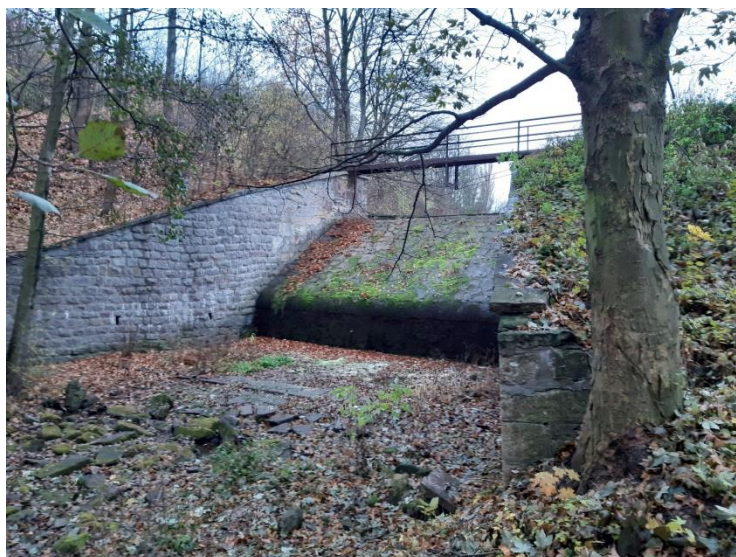
Obrázek 44 Rybník Podviňák, skluz a vývařiště bezpečnostního přelivu. Jiří Václavek
