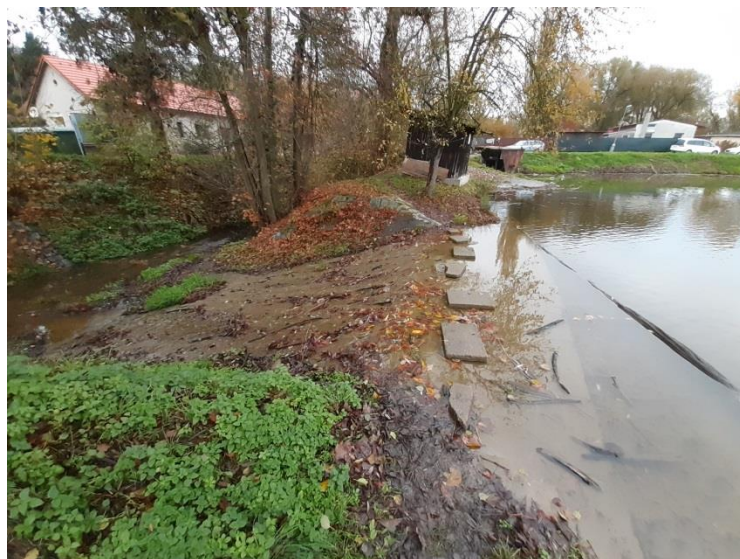
Obrázek 40 Bezpečnostní přepad v boční hrázi Mlýnského rybníka, Zahrady. Jiří Václavek
