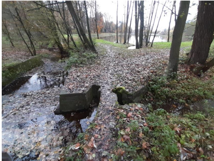
Obrázek 39 Systém napájení a obtoku Mlýnského (Tuchorazského) rybníka. Jiří Václavek
