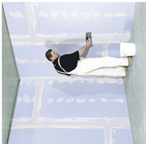
Zarovnávání povrchu zahlazením otvorů a spár 17)
