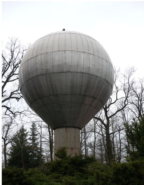
Obrázek č. 3: Vodojem pro provozní vodu
