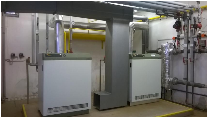
Obr. 3 Umístění kotle K1 a K2 na pracovišti
