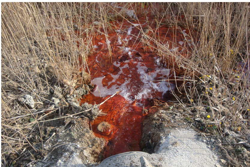
Foto č. 7: Vyústění meliorační drenáže do nádrže č. 101
