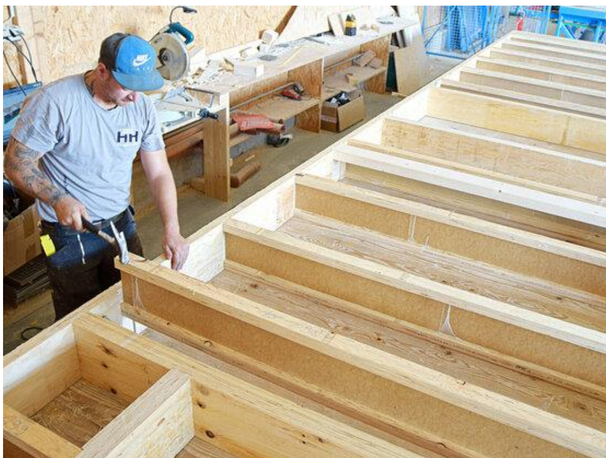
Obrázek 10 - Prefabrikace nosného rámu stěny z I nosníků Steico (Steico ©2024)
