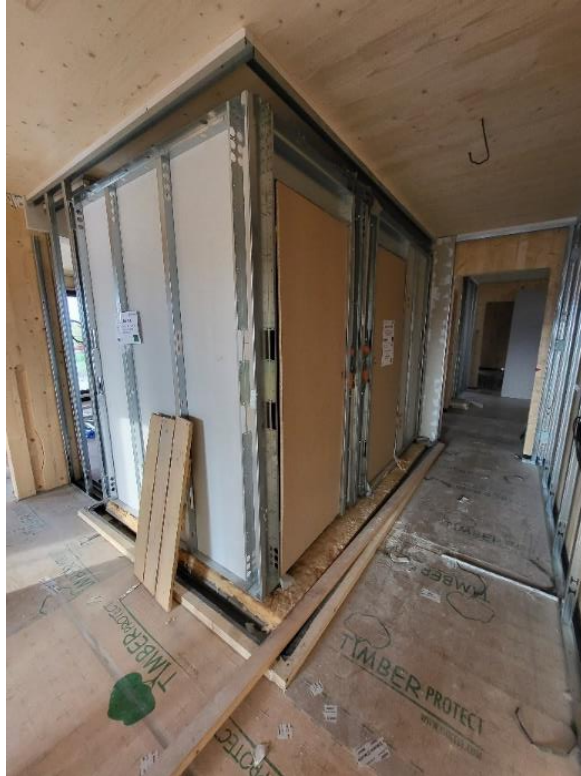
Obrázek 4 - Koupelnový modul Sanika osazený v rozestavěné bytové stavbě z CLT panelů (autor práce, 2023)
