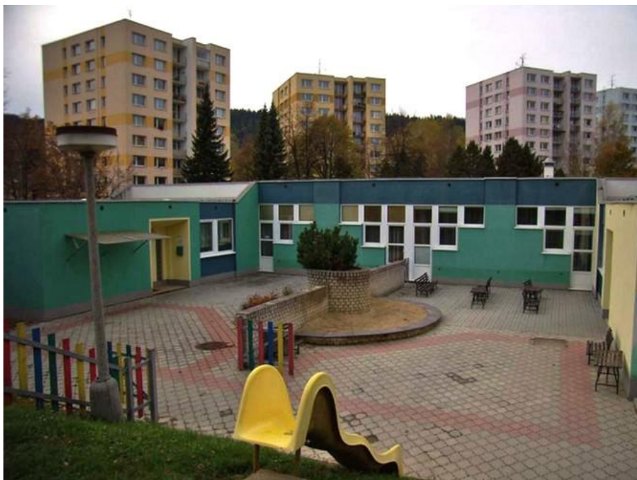
53/ Libor Erban, mateřská škola a jesle v bývalé Rogačevské ulici (1975 – 1977), současný stav. Foto: Archiv NPÚ Č. Budějovice.
