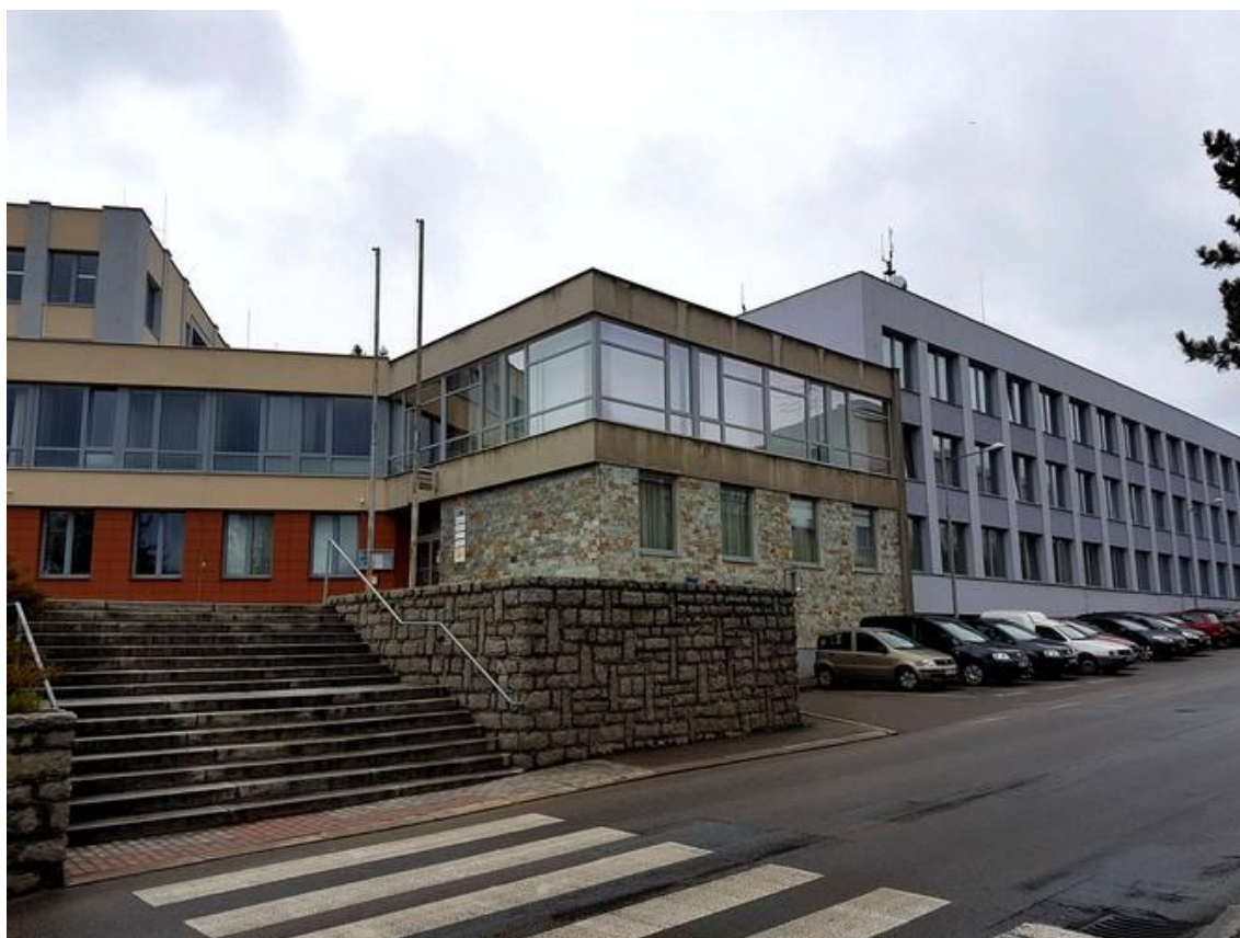
42/ Jaroslav Daněk, administrativní budova SNB a soudu, současný stav. Foto: Autorka.
