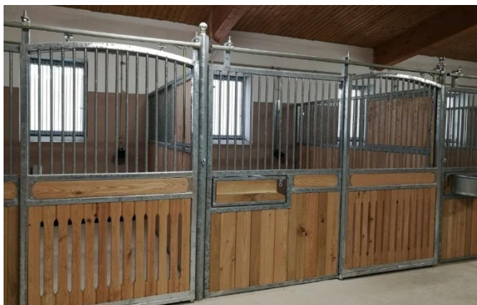
Obrázek 5 - výplň stěny boxu s průduchy
