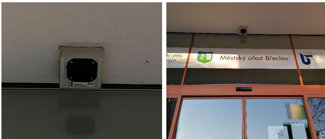
Obr. 19a, 19b – Digitální hlasový orientační majáček a jeho správné umístění
