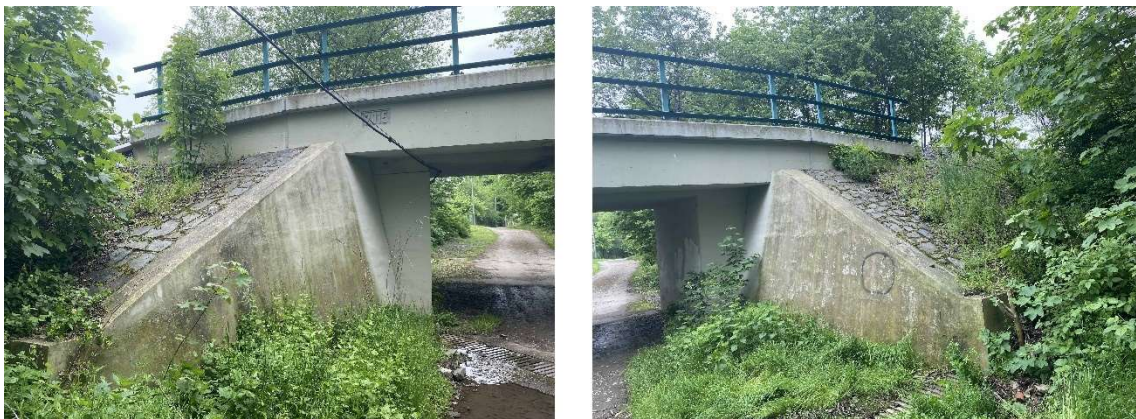
Obr. 11 Prefabrikovaný železniční most na TU2131 v km 77,371
