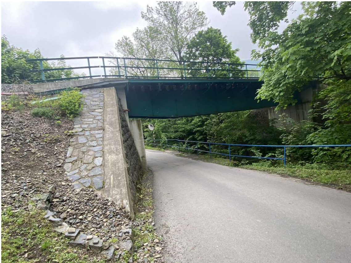
Obr. 12 Ocelový železniční most na TU2131 v km 78,007
