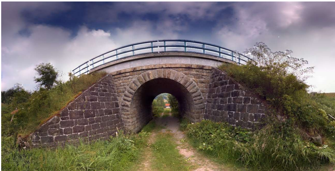
Obr. 13 Kamenný železniční most na TU2131 v km 79,479
