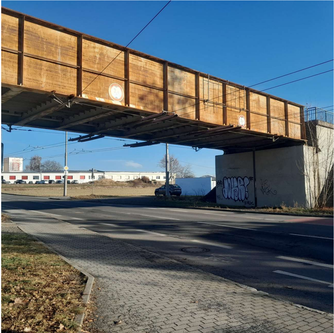
Obr. 14 Ocelový železniční most na TU2252 v km 114,800
