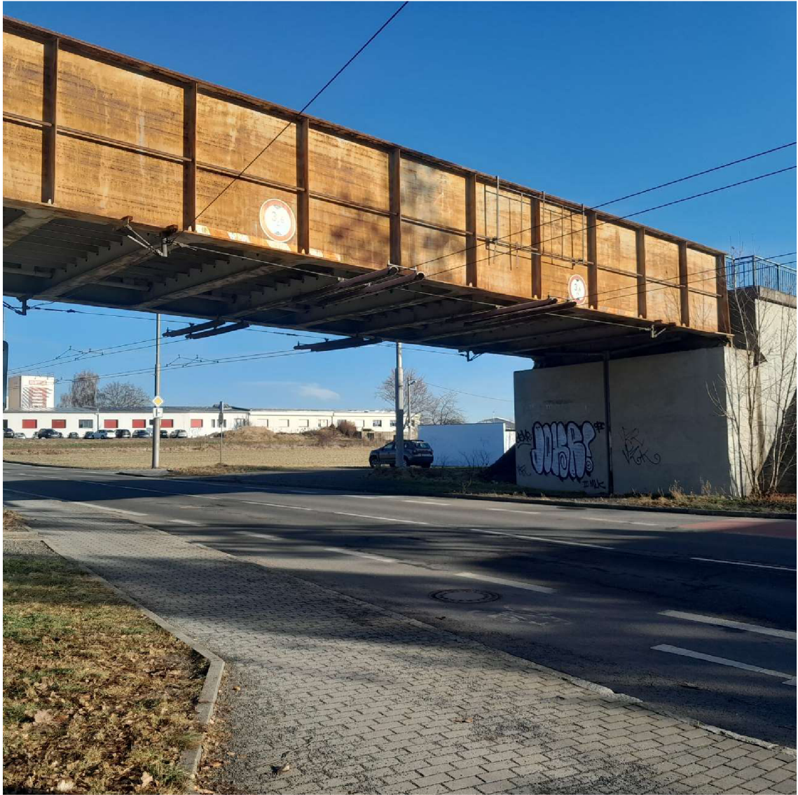
Obr. 14 Ocelový železniční most na TU2252 v km 114,800
