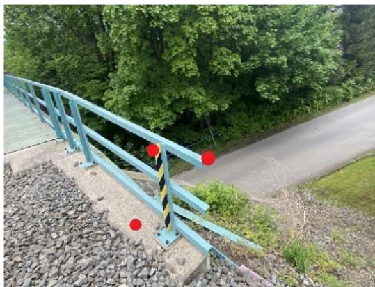
Obr. 15 Ukázka umístění vlíčovacích a kontrolních bodů
