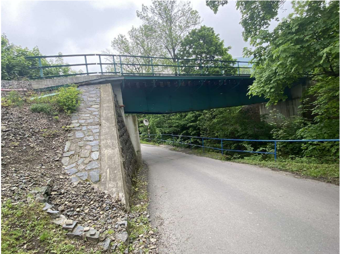
Obr. 12 Ocelový železniční most na TU2131 v km 78,007
