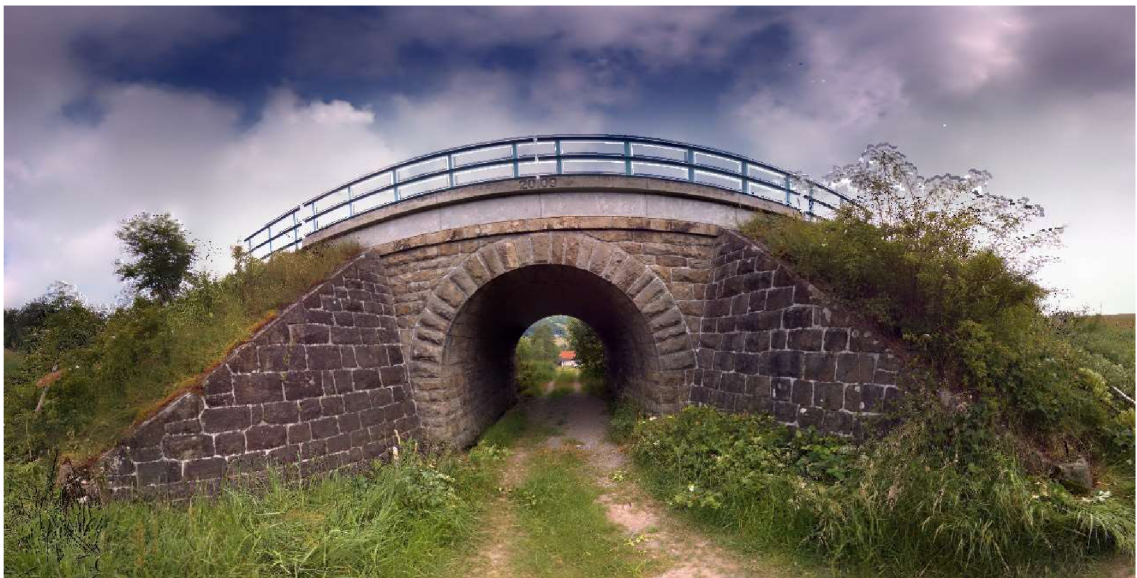
Obr. 13 Kamenný železniční most na TU2131 v km 79,479
