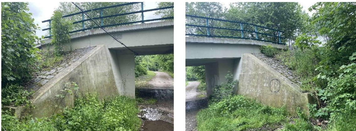
Obr. 11 Prefabrikovaný železniční most na TU2131 v km 77,371
