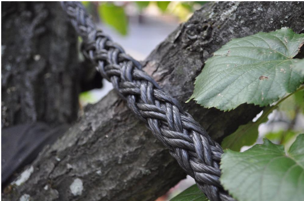
Obr. 69 Jiřická lípa – špatná instalace, umístit vazbu jinak, či krytí dutinkou, foto: Petr Zvědělík, září 2015
