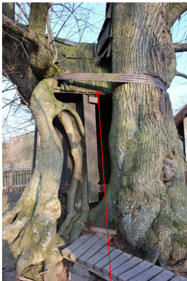
Obr. 25 Klokočovská lípa – podpěrná konstrukce uvnitř dutiny, foto: Petr Zvědělík, duben 2015
