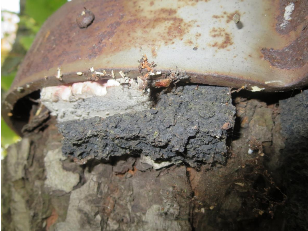
Obr. 62 Jiřická lípa – betonová podkladnice podložená gumou, foto: Petr Zvědělík, září 2015
