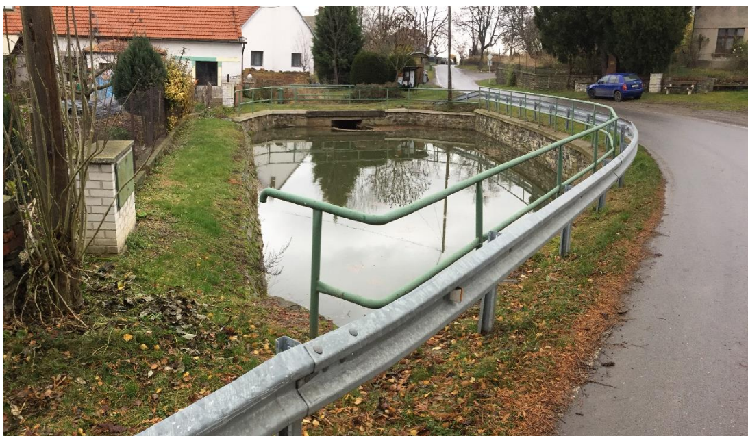
Obrázek 15: Požární nádrž Na Návsi 2 v Chrástu, fotografie autor, rok pořízení 11/2019
