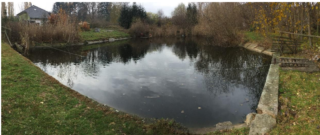
Obrázek 11: Požární nádrž v Krupé, fotografie autor, rok pořízení 11/2019
