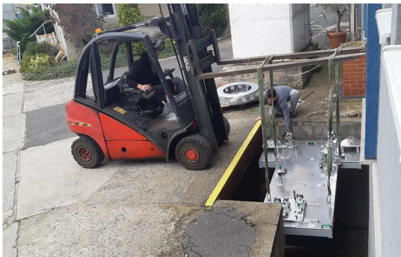
Obrázek 13: Přesun kontrolního přípravku na měřící středisko
